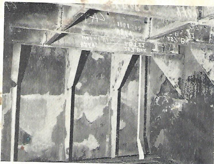
Inwendige van een tank vóór de conservering
